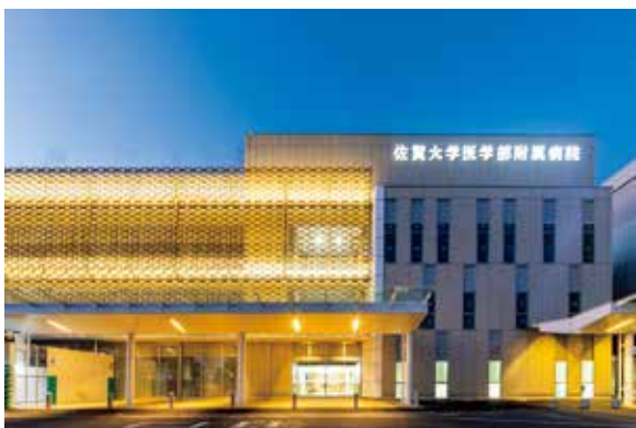
病院正面玄関・外来Ⅰ期工事完成時（令和元年10月）
